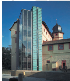
Ansicht von Norden, neuer Treppen- und Aufzugsturm
